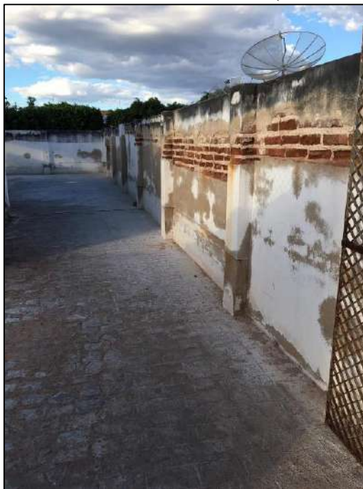
Figura 03: Fachada Interna do Muro (Lateral Direita)
