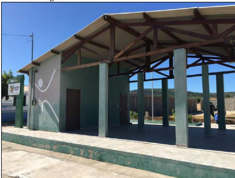
Figura 04: Fachada Lateral Direita do Prédio.
