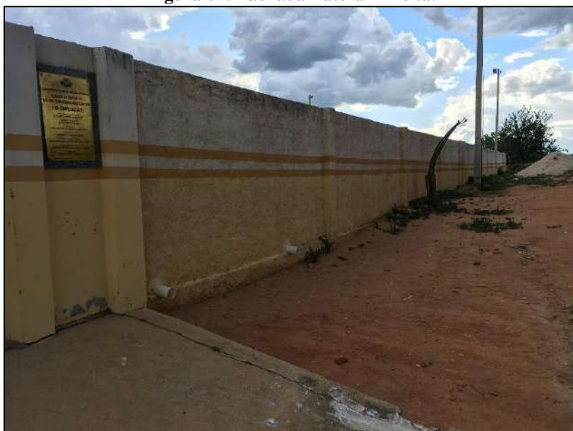
Figura 02: Fachada Lateral Direita.
