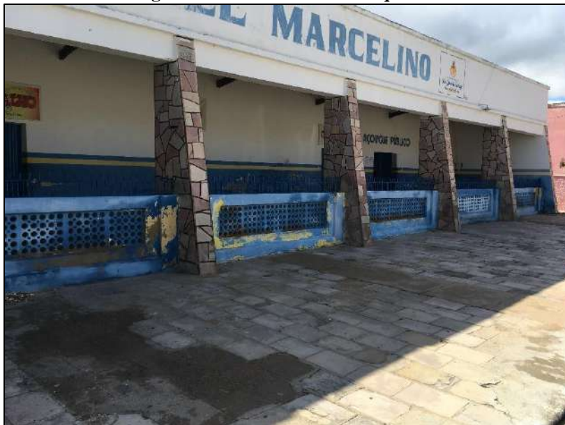
Figura 03: Fachada Frontal Esquerda.
