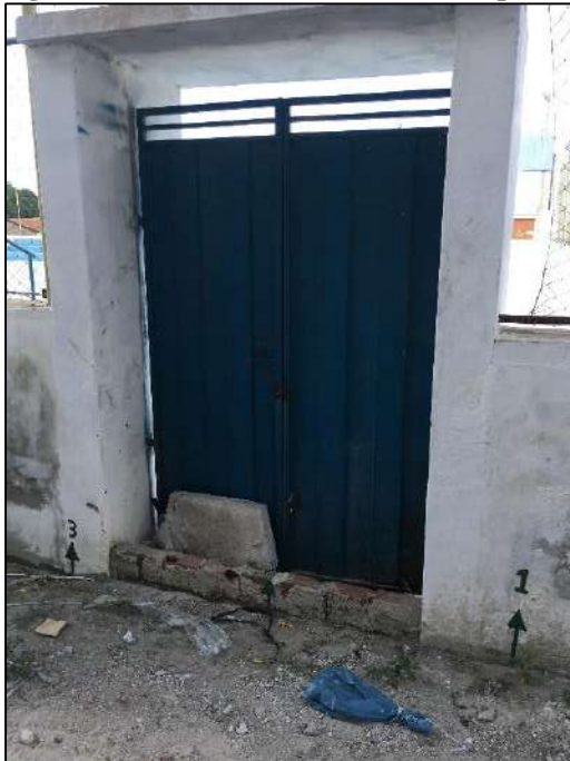
Figura 05: Portão, Fachada Lateral Esquerda
