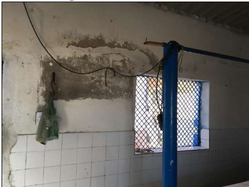
Figura 13: Parede Interna do Box 01
