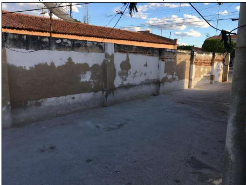
Figura 04: Fachada Interna do Muro (Lateral Direita)
