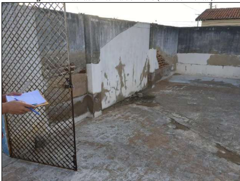
Figura 02: Fachada Interna do Muro (Parede Frontal).
