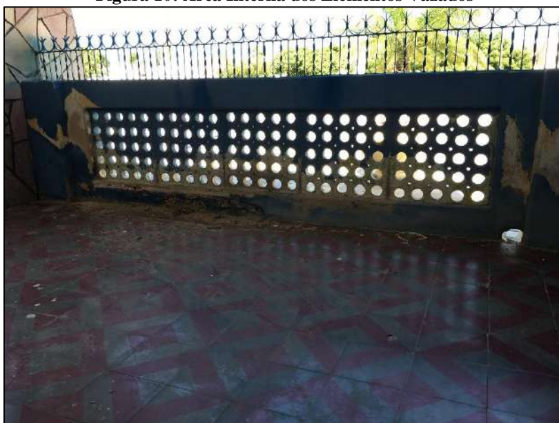
Figura 10: Área Interna dos Elementos Vazados
