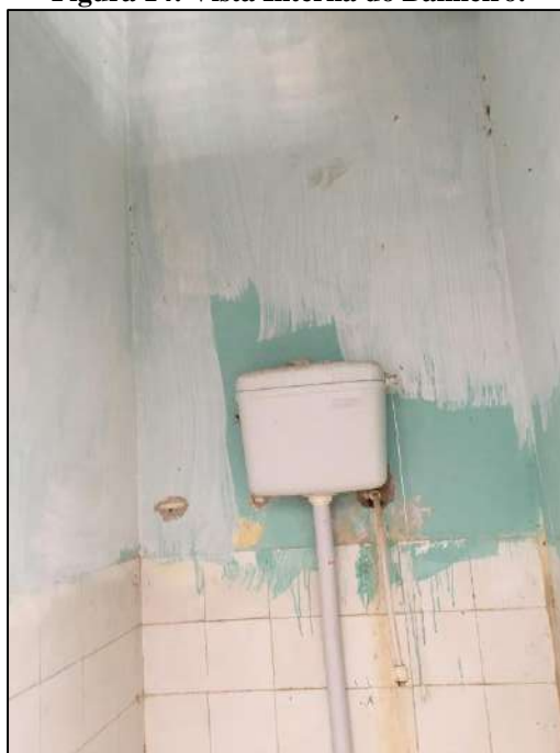
Figura 14: Vista Interna do Banheiro.
