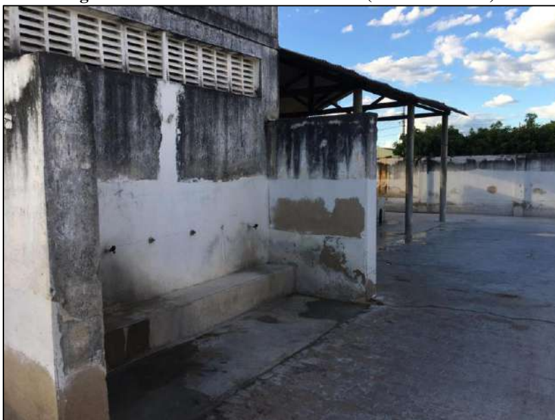
Figura 07: Fachada Interna do Prédio (Lateral Direita).
