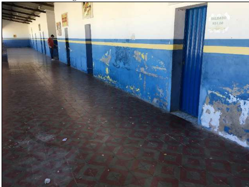
Figura 11: Parede Interna dos Box.
