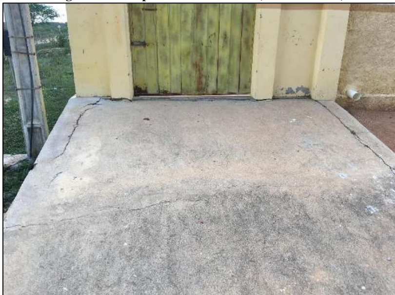
Figura 03: Rampa de Acessibilidade (lateral Direita).
