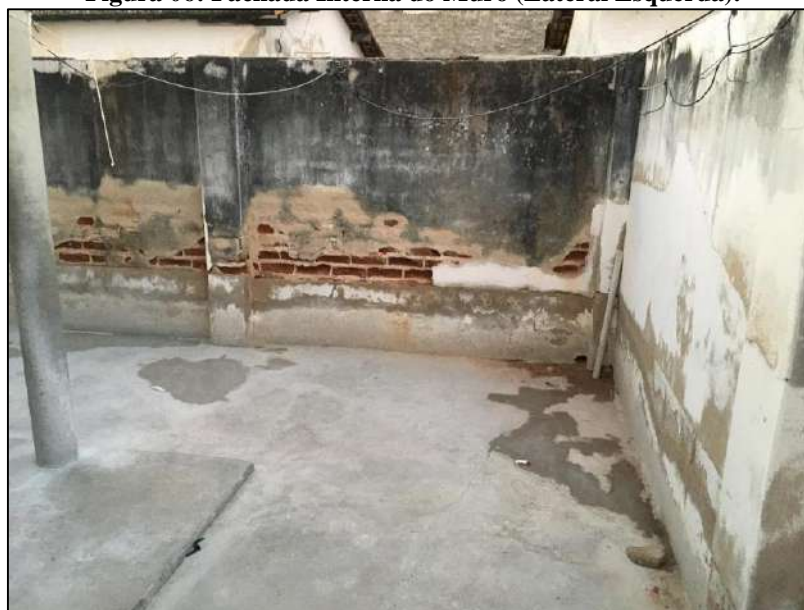
Figura 06: Fachada Interna do Muro (Lateral Esquerda).
