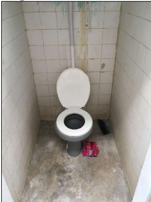
Figura 15: Vista Interna do Banheiro.
