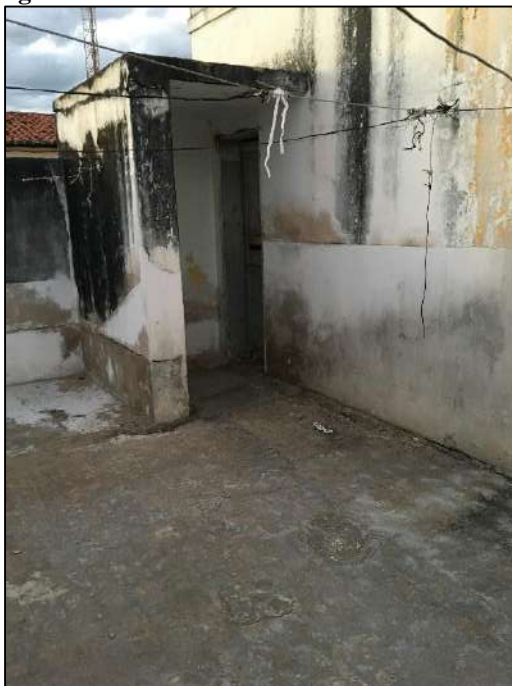
Figura 08: Fachada Interna Frontal do Prédio.
