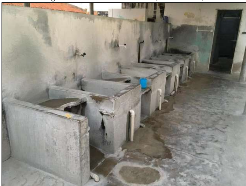
Figura 09: Vista da Lavanderia (Lado Direito).
