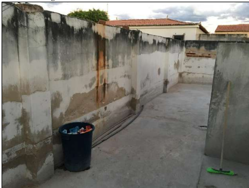
Figura 05: Fachada Posterior Interna do Muro.
