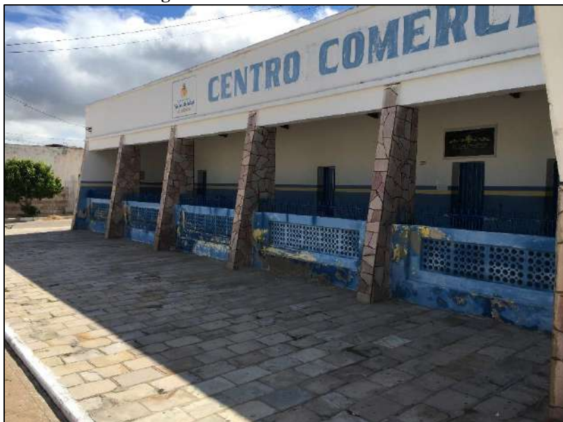
Figura 02: Fachada Frontal Direita.
