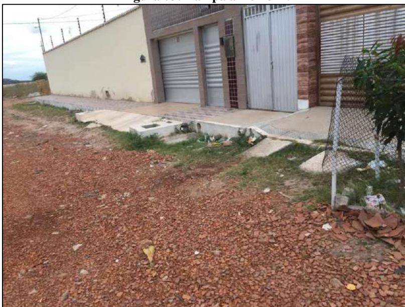
Figura 03: Rampa a Demolir.
