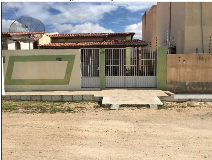
Figura 06: Rampa a Demolir.
