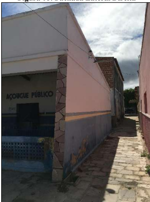
Figura 08: Fachada Lateral Direita
