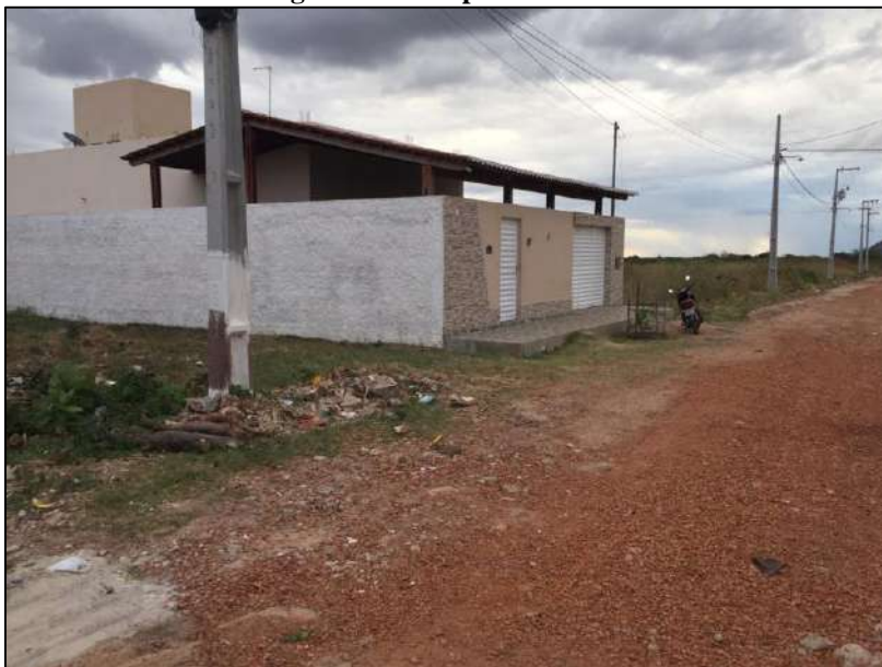
Figura 04: Rampa a Demolir.
