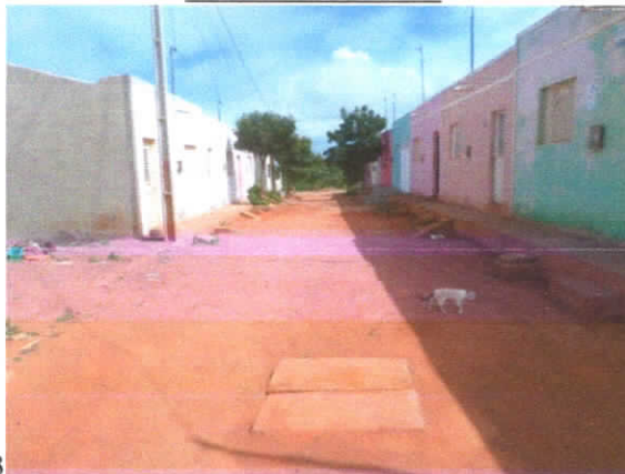
Estaca E2 Sentido E1
