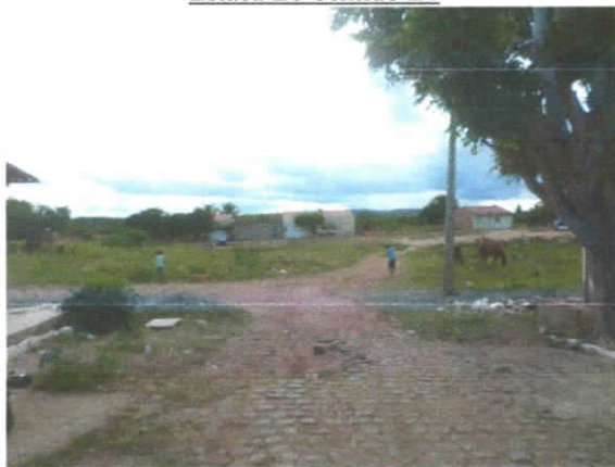
Estaca E0 Sentido E1
