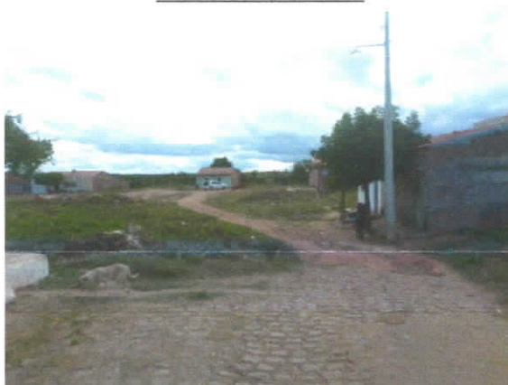
Estaca E0 Sentido E1
