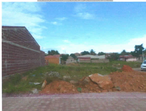
Estaca E3+0.80 Sentido E3
