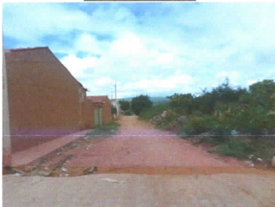
Estaca E0 Sentido E1
