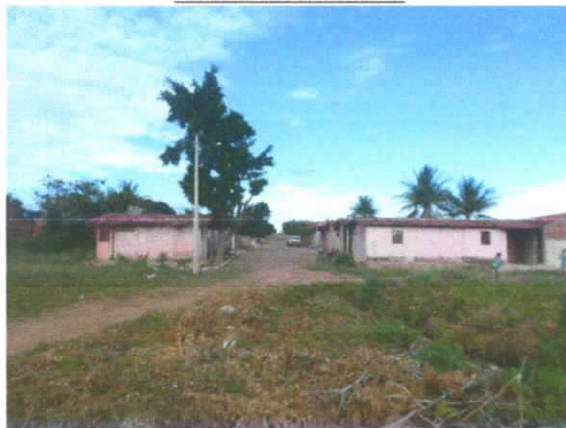
Estaca E2 Sentido E1
