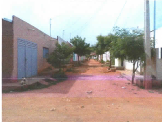
Estaca E0 Sentido E1
