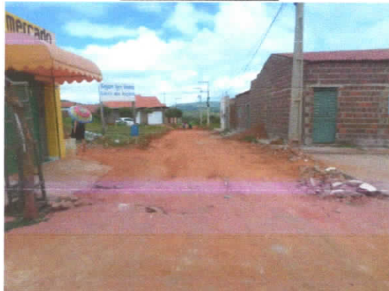
Estaca E0 Sentido E1
