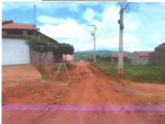
Estaca E2 Sentido E2+8.00
