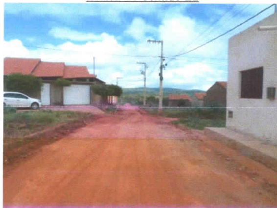
Estaca E1 Sentido E2
