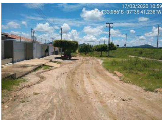
RUA TEREZINHA DE CASTRO
