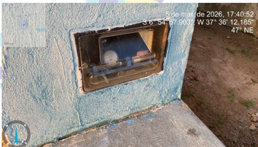
Foto 10: Fornecimento de água potável em imóvel adjacente
