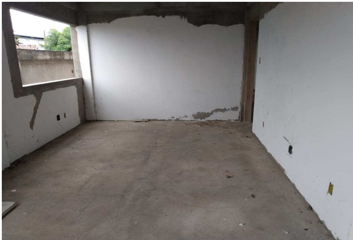
Foto 06 - SALA DE COORDENAÇÃO/ADMINISTRAÇÃO
