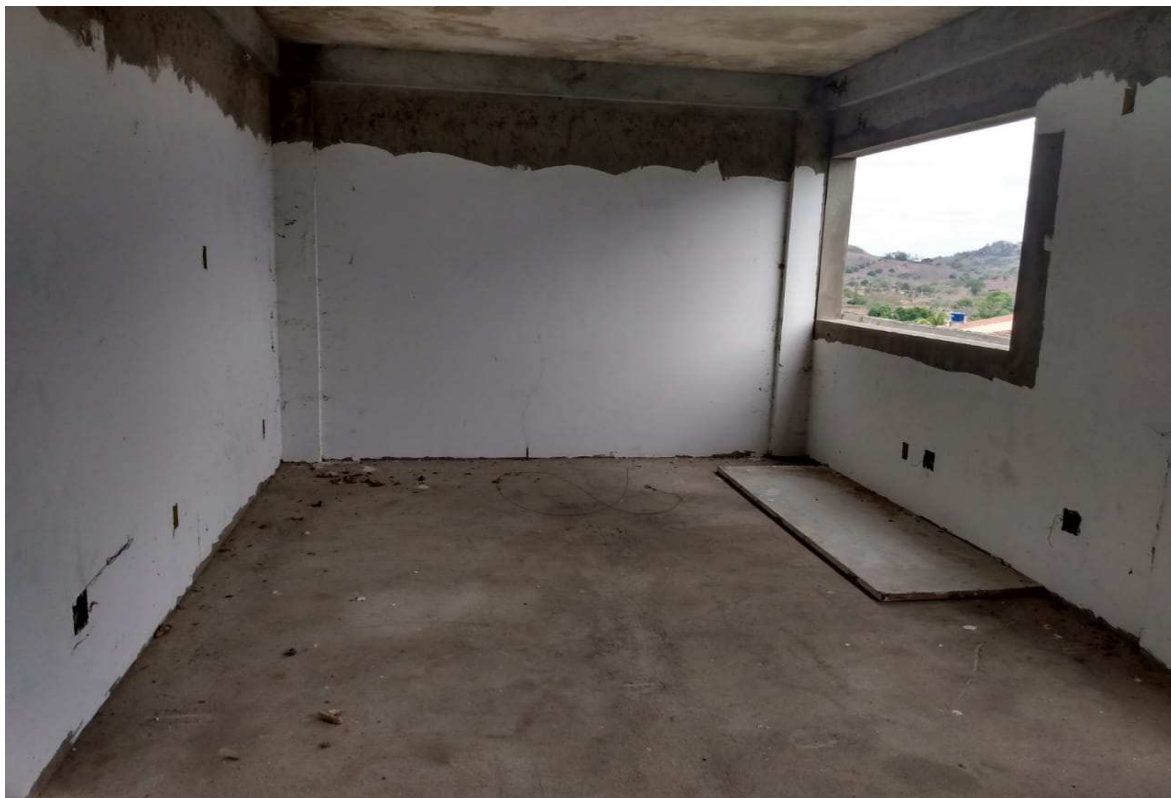
Foto 07 - SALA DE COORDENAÇÃO/ADMINISTRAÇÃO
