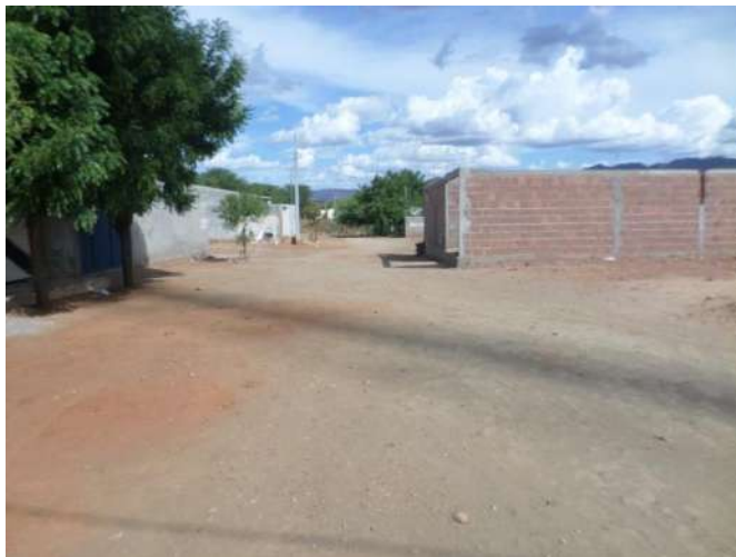
Estaca E1 Sentido E3+10.30
