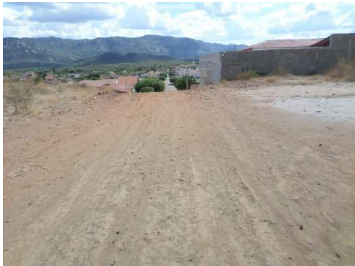
Estaca E4 Sentido E0
