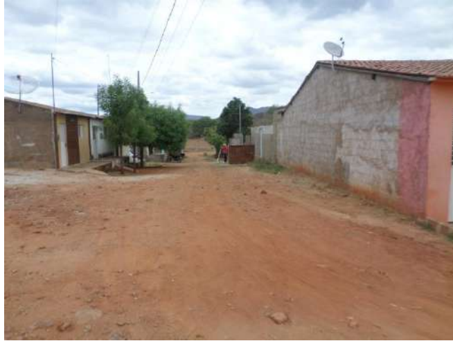
Estaca E1 Sentido E0
