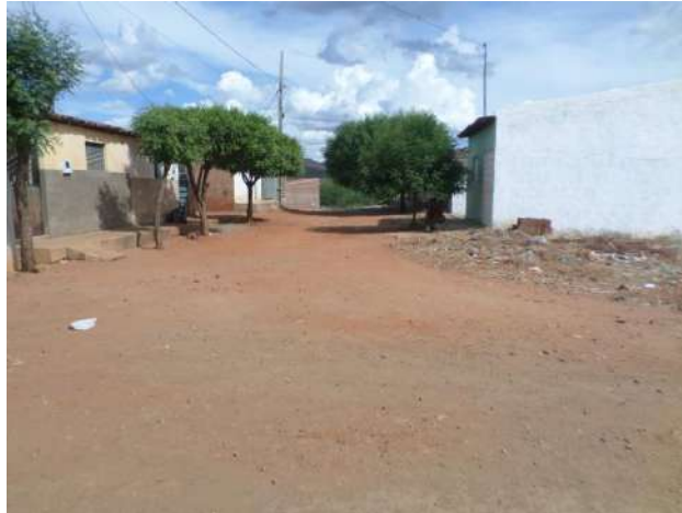
Estaca E1 Sentido E1+13.35
