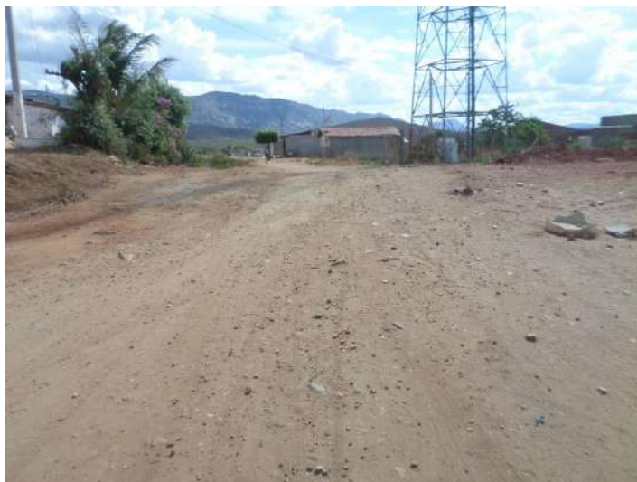
Estaca E7 Sentido E0
