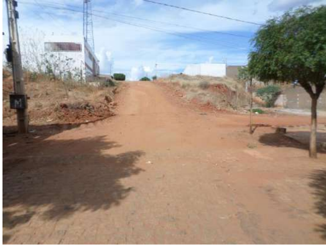
Estaca E1 Sentido E0
