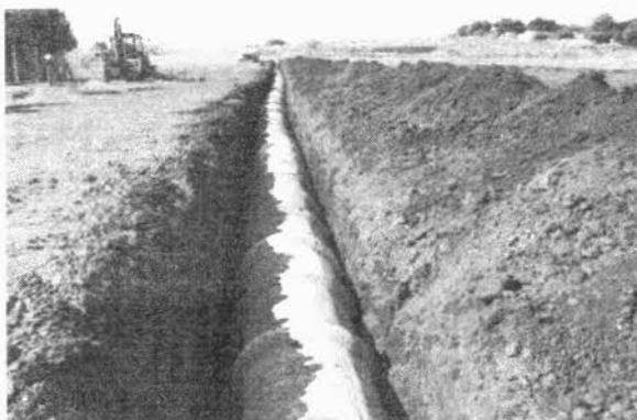
Figura 4. Instalação de galeria
