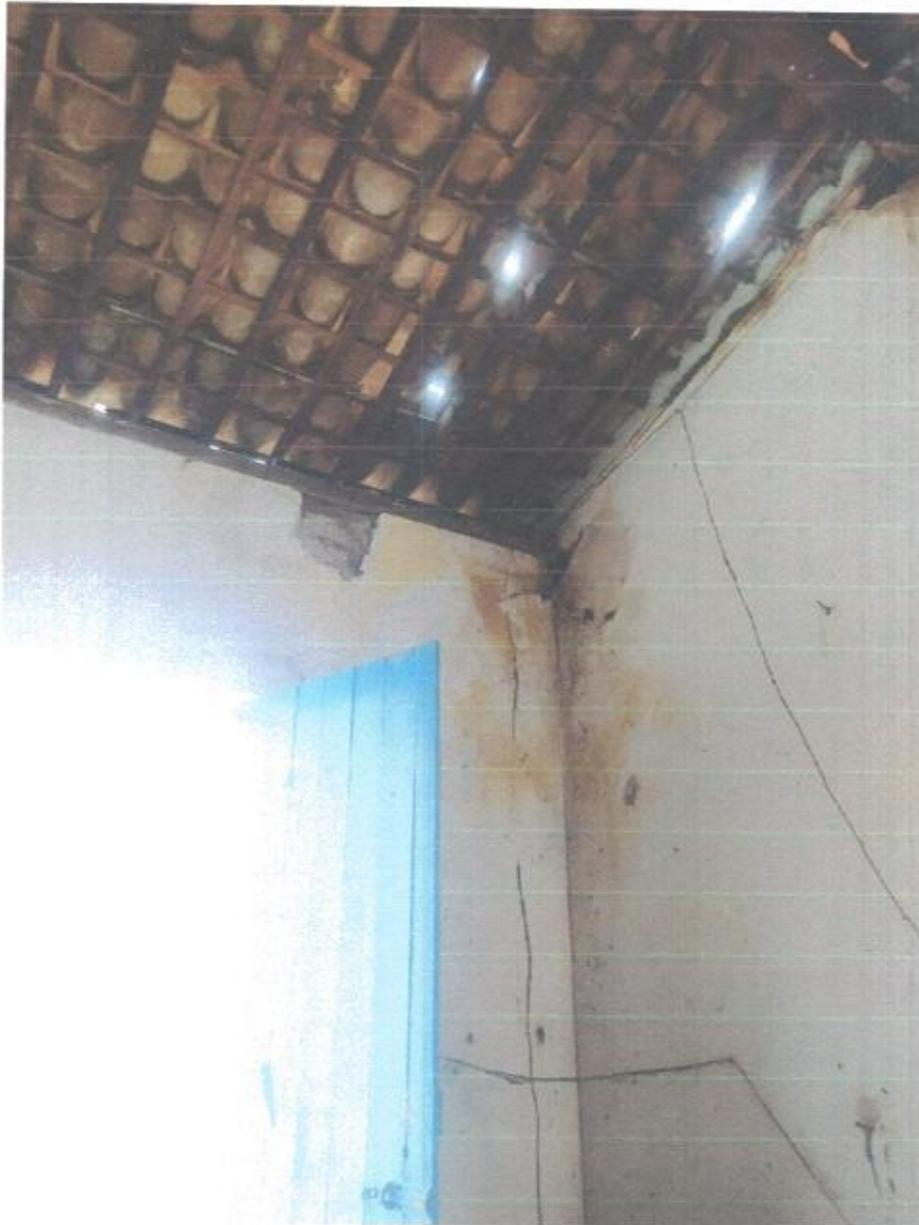
Foto 03: Vista interna - Coberta comprometida, instalações elétricas expostas, revestimento danificado, esquadrias sem condições de uso.
