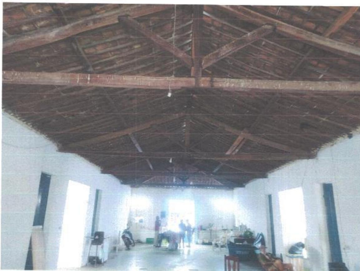
Foto 02: Vista interna - Coberta comprometida, instalações elétricas expostas
