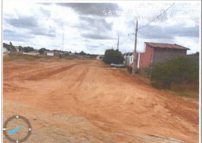
Foto 4: RUA JOSÉ DE SOUSA GOMES - TRECHO 01
