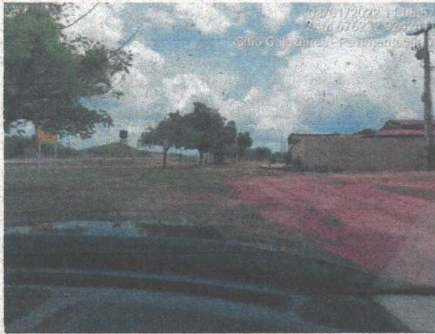
RUA PROJETADA 07 - SÍTIO CAJAZEIRAS
