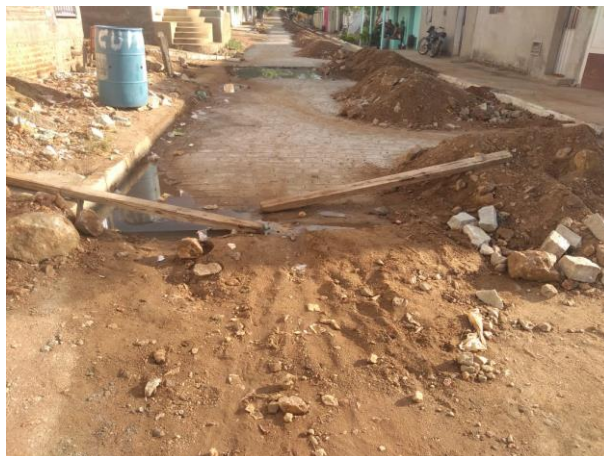
Figura 9: Fim do calçamento existente da Rua José Antônio de Oliveira
