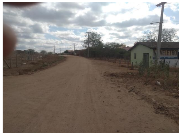
Figura 4: Trecho final do calçamento -E10+13
