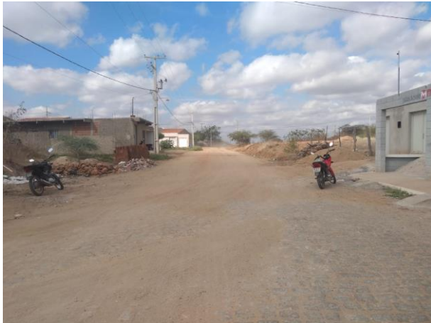
Figura 1: Início do trecho á pavimentar- Estaca 0
