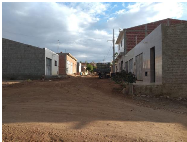
Figura 8: Trecho sem pavimentação da Rua José Antônio de Oliveira
