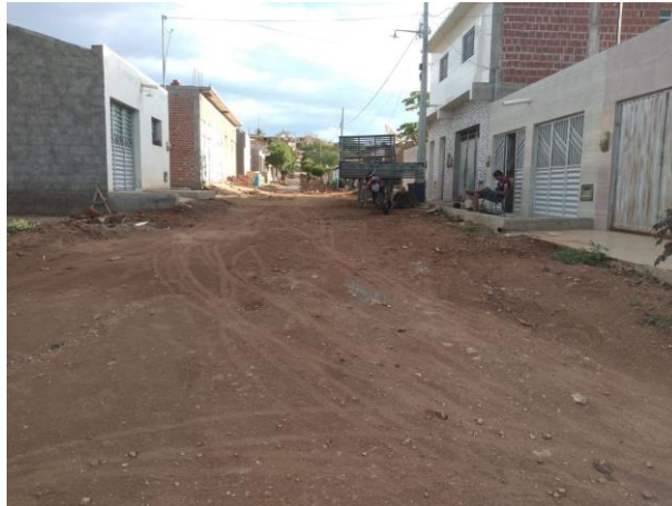
Figura 7: Trecho sem pavimentação da Rua José Antônio de Oliveira
