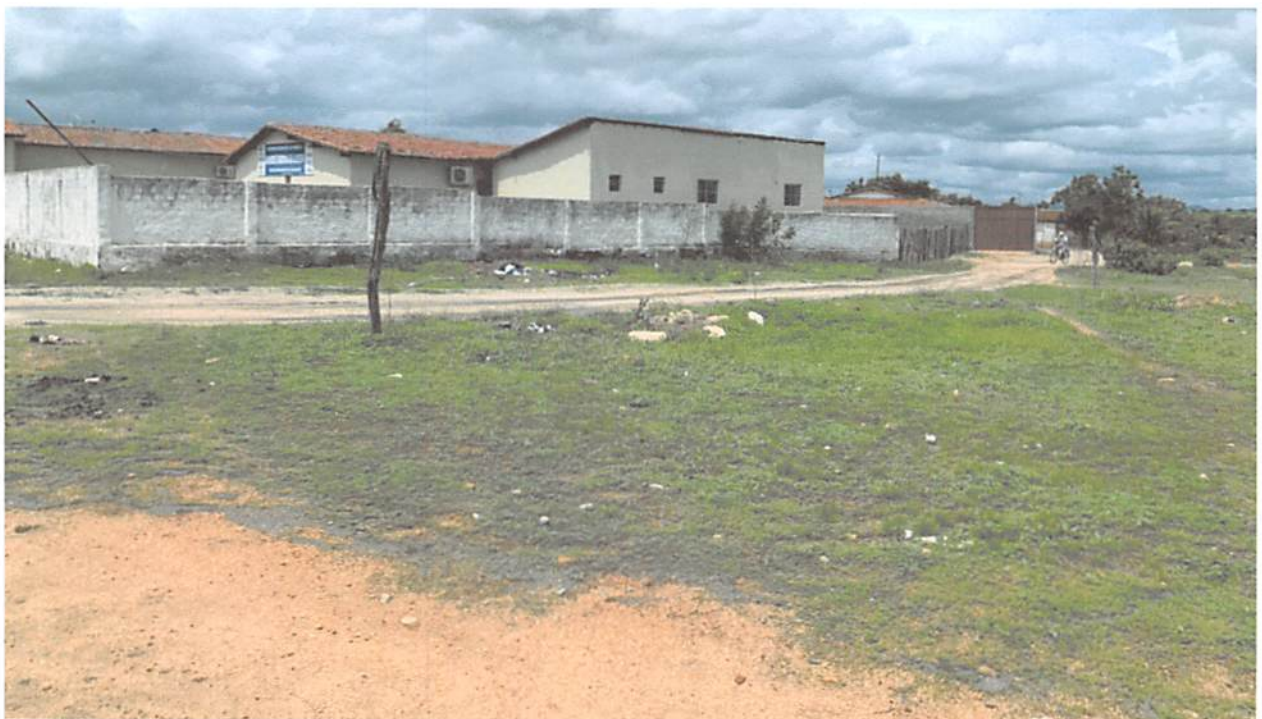
Foto 02 – Entorno do local de construção da Quadra
