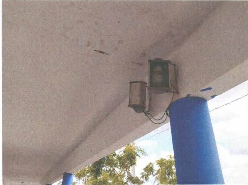
Figura 18 Instalações elétricas expostas
