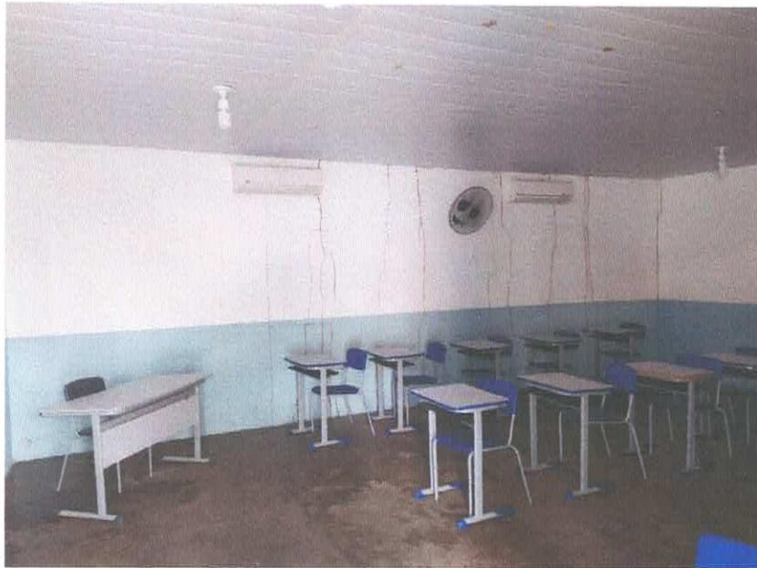
**Figura 2** Marcas de vazamento e cupim no telhado
