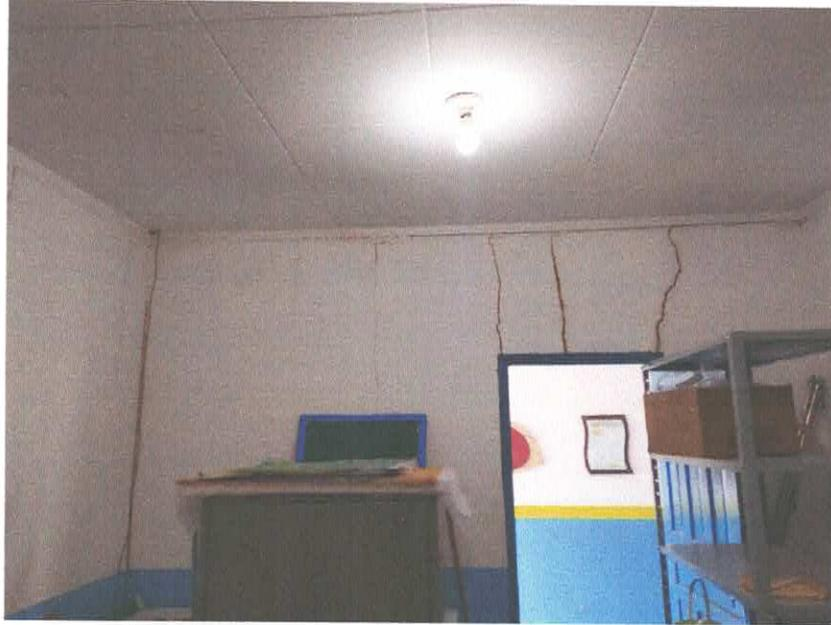
Figura 4 Marcas de vazamentos no telhado
