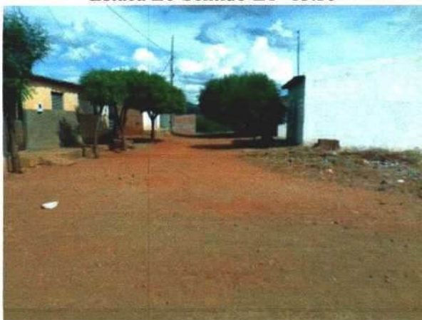
Estaca E1 Sentido E1+13.35
