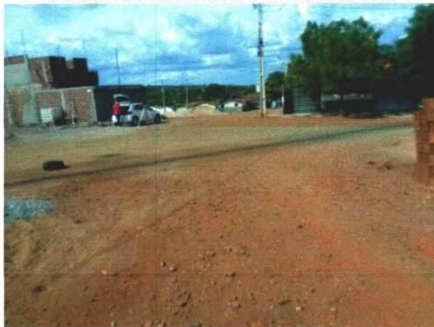
Estaca E1 Sentido E0
