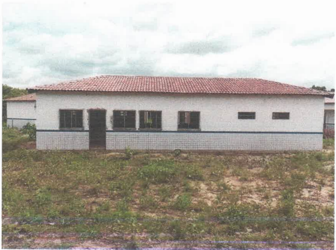
Foto 01: Limpeza externa e retirada dos entulhos da obra, presença apenas de vegetação rasteira, pois está no período chuvoso na região, e a vegetação brota rápido.
