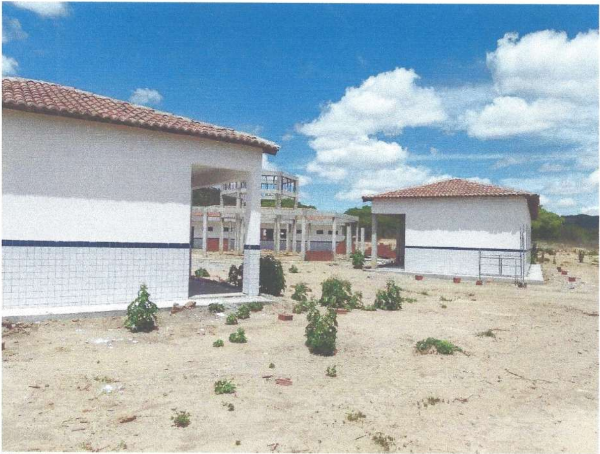
FIGURA 02: Vista lateral do terreno
