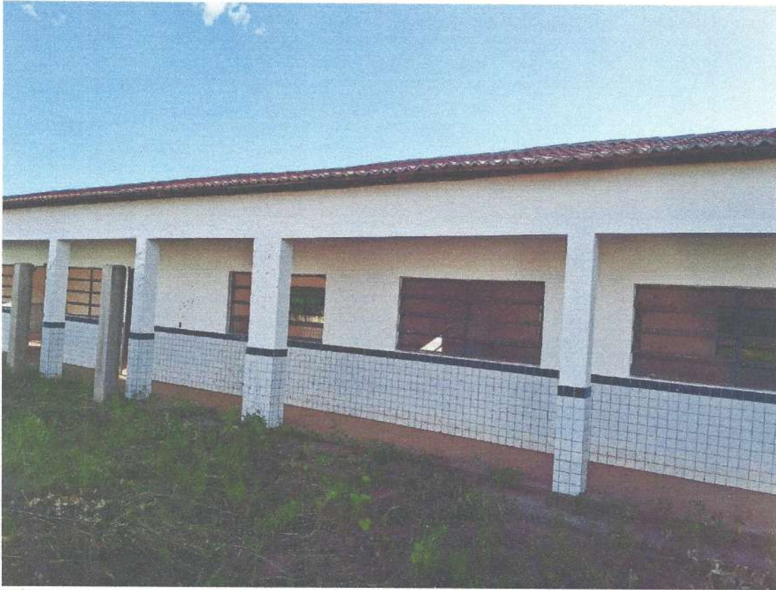
FIGURA 05: Bloco pedagógico – vista frontal
