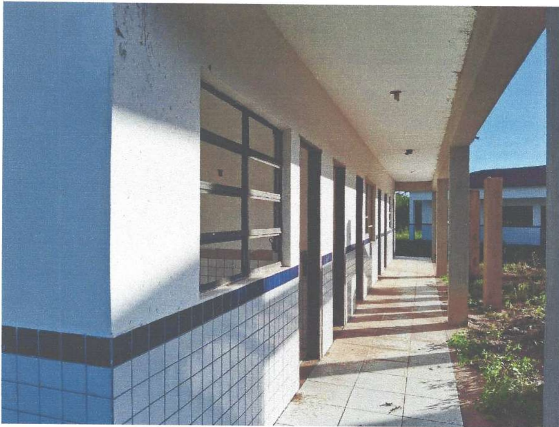
FIGURA 09: Vista externa bloco administrativo
