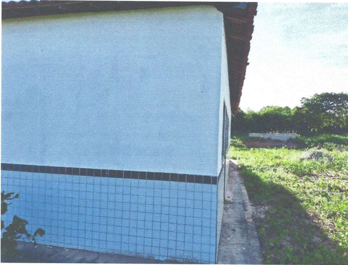
FIGURA 12: Detalhe do acabamento da área externa do bloco de serviços
