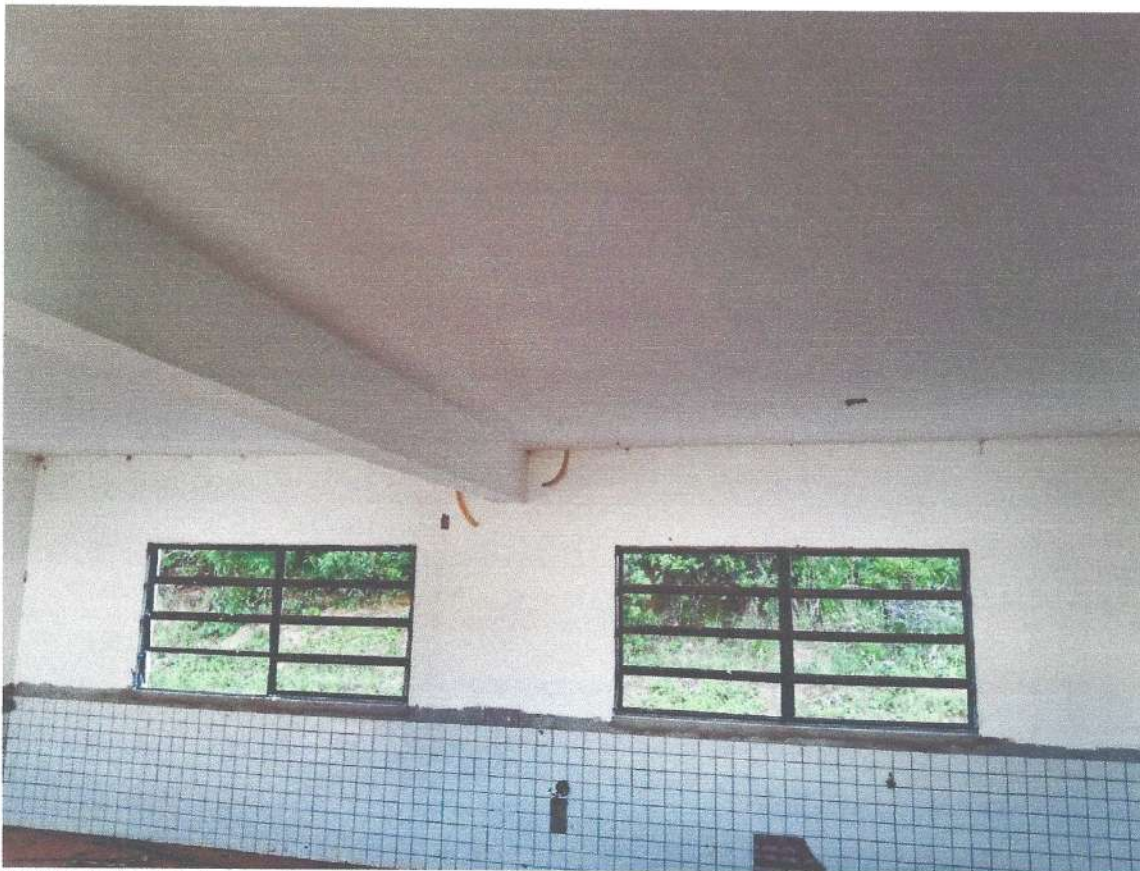
FIGURA 06: vista interna das salas, com revestimento, emassamento em bom estado de conservação..
