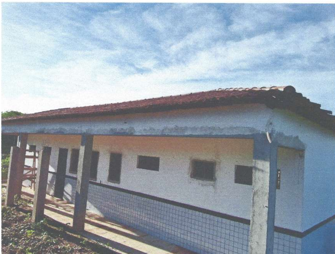
FIGURA 11: Vista externa do bloco de serviços
