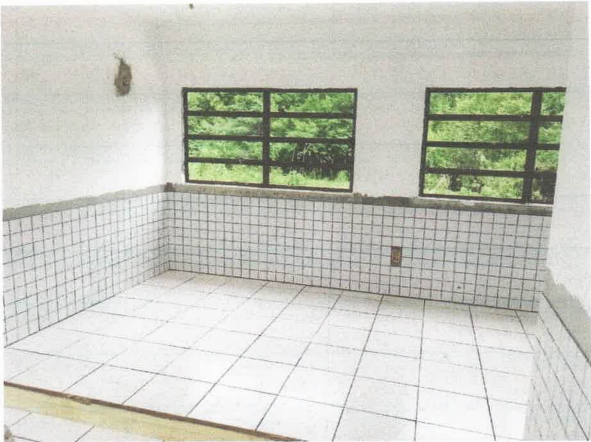
Foto 02: Limpeza interna e retirada dos entulhos da obra devidamente executada conforme recomendação.
