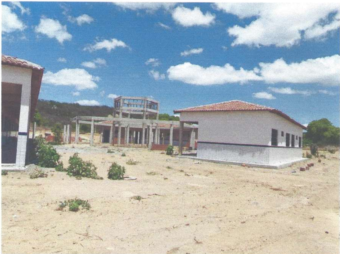
FIGURA 03: Vista lateral do terreno
