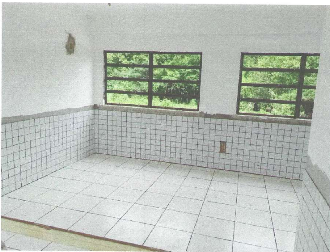
FIGURA 10: Vista interna bloco administrativo
