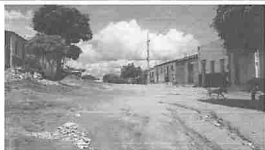
Figura 1: Rua José Genuíno – Trecho 2 a ser pavimentado.
