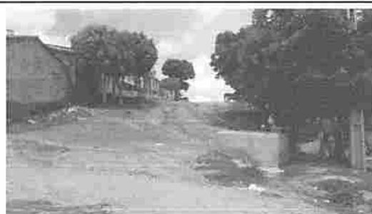
Figura 3: Rua José Genuíno – Trecho 2 a ser pavimentado
