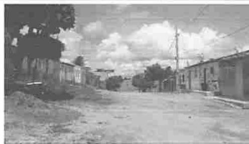
Figura 2: Rua José Genuíno – Trecho 2 a ser pavimentado.
