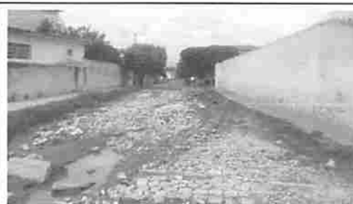
Figura 2: Rua Francisco Bezerra Araújo Galvão trecho inicial. Próximo ao Fórum.
