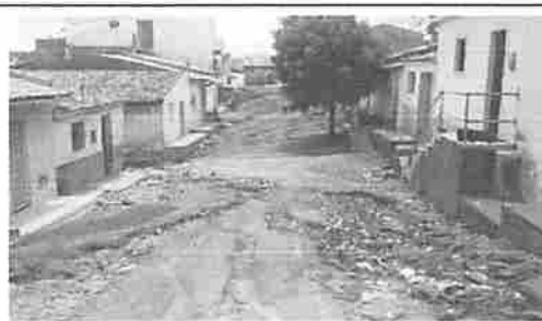
Figura 4: Rua José Genuíno – Trecho 2 a ser pavimentado
