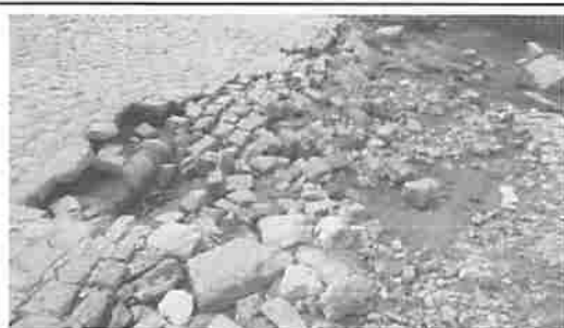
Figura 1: Rua Francisco Bezerra Araújo Galvão trecho inicial. Próximo ao Fórum.
