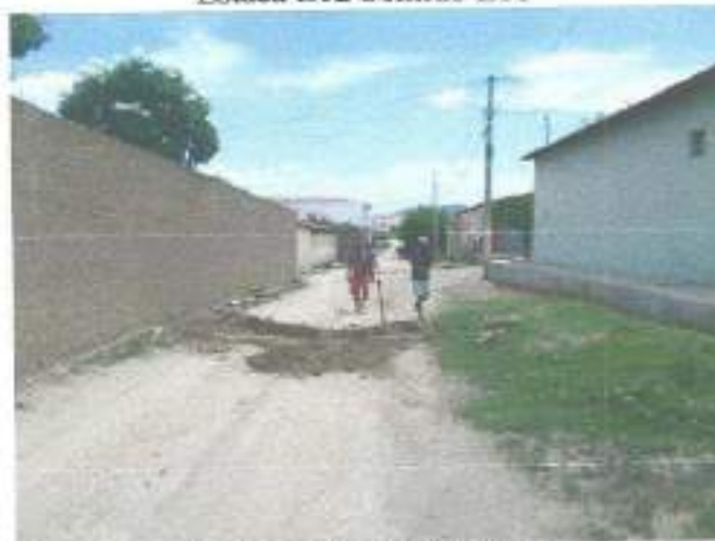
Estaca E13 Sentido E12
