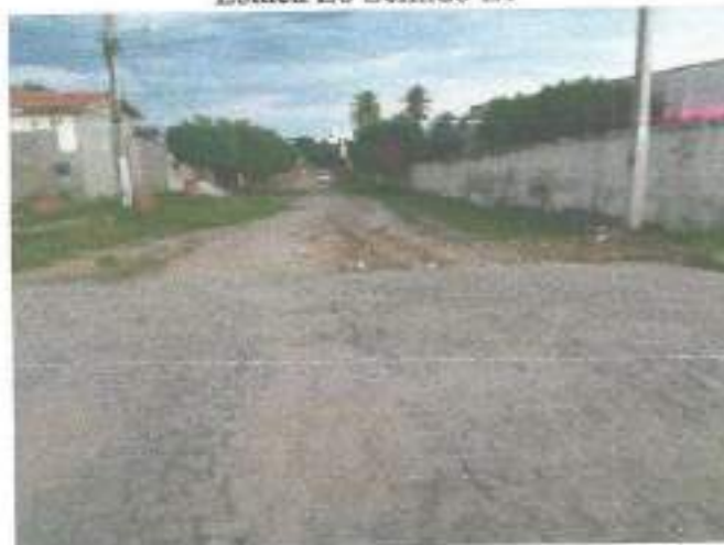
Estaca E1 Sentido E0
