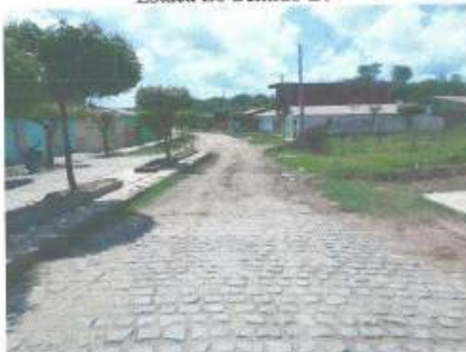
Estaca E1 Sentido E2
