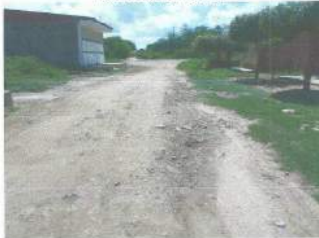
Estaca E3 Sentido E4
