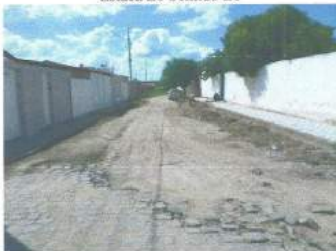
Estaca E1 Sentido E2
