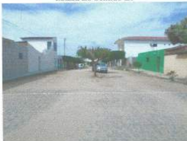
Estaca E1 Sentido E0
