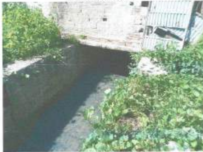
Detalhe do Canal
