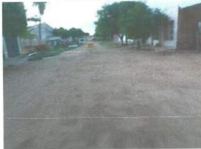
Estaca E6 Sentido E5
