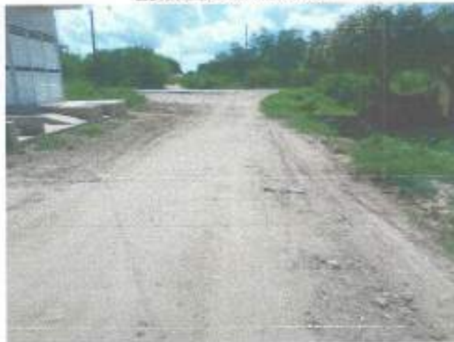
Estaca E4 Sentido E5
