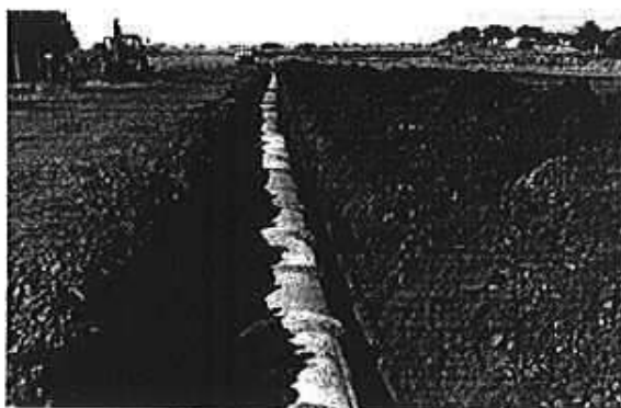
Figura 4. Instalação de galeria
