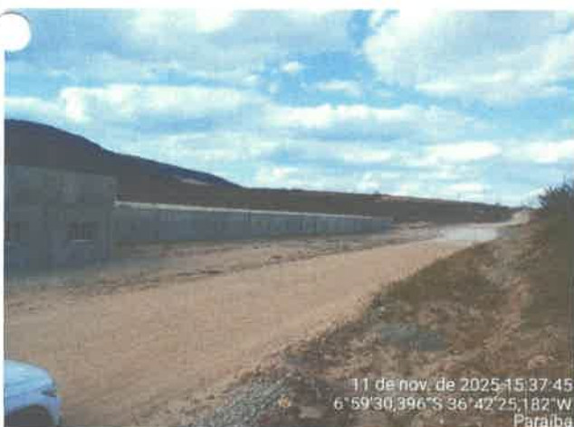
RUA PROJETADA 1 ACESSO AO CAMPO DE FUTEBOL
