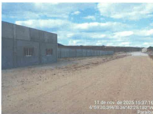
RUA PROJETADA 1 ACESSO AO CAMPO DE FUTEBOL
