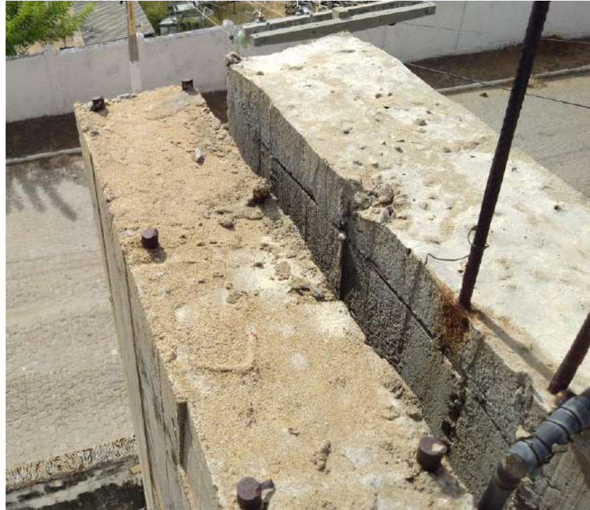
Figura 22 – Esperas cortadas e expostas
