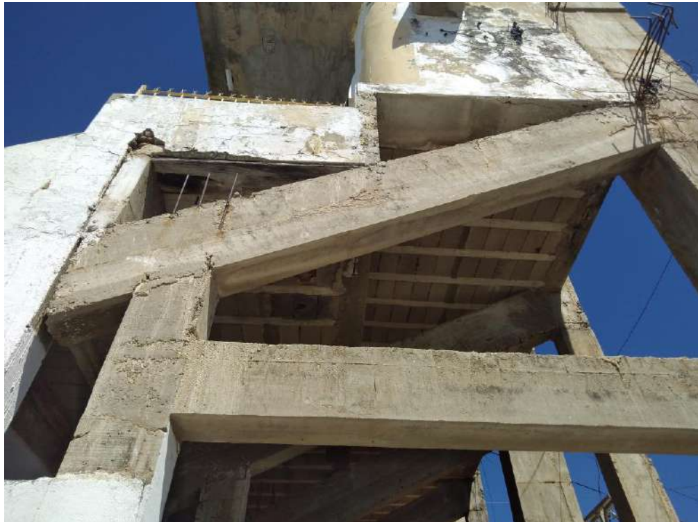
Figura 3(a) – Estrutura de suporte das arquivancadas cobertas
