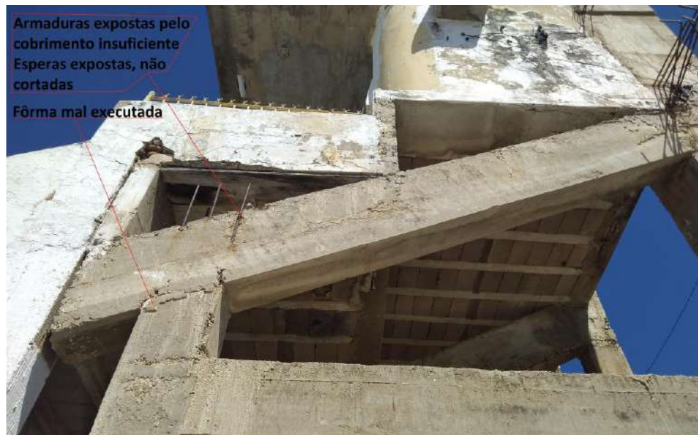
Figura 23 – Pilares da estrutura de suporte
