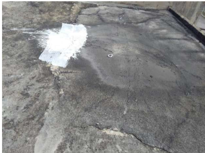
Figura 16 – Argamassa no centro da laje
