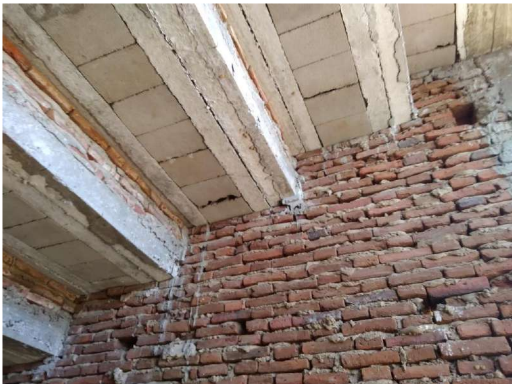
Figura 3(b) – Estrutura apoiada em alvenaria
