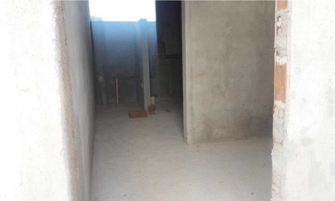
Foto 10 – Chapisco, reboco, parte do hidro-sanitário.
