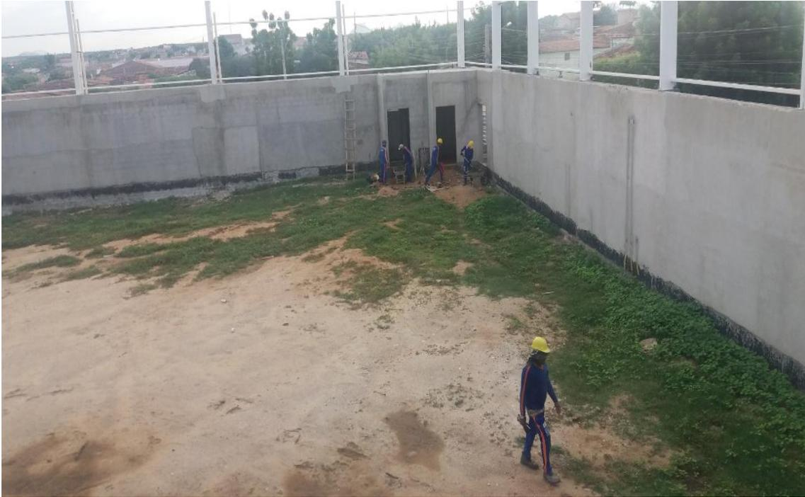
Foto 08 – Chapisco, reboco, parte do hidro-sanitário.
