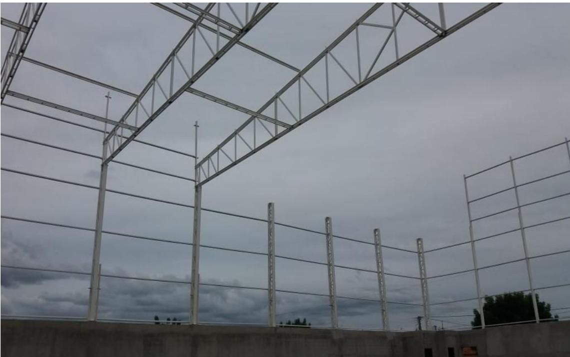
Foto 07 – Superestrutura, fechamento em alvenaria e estrutura metálica.
