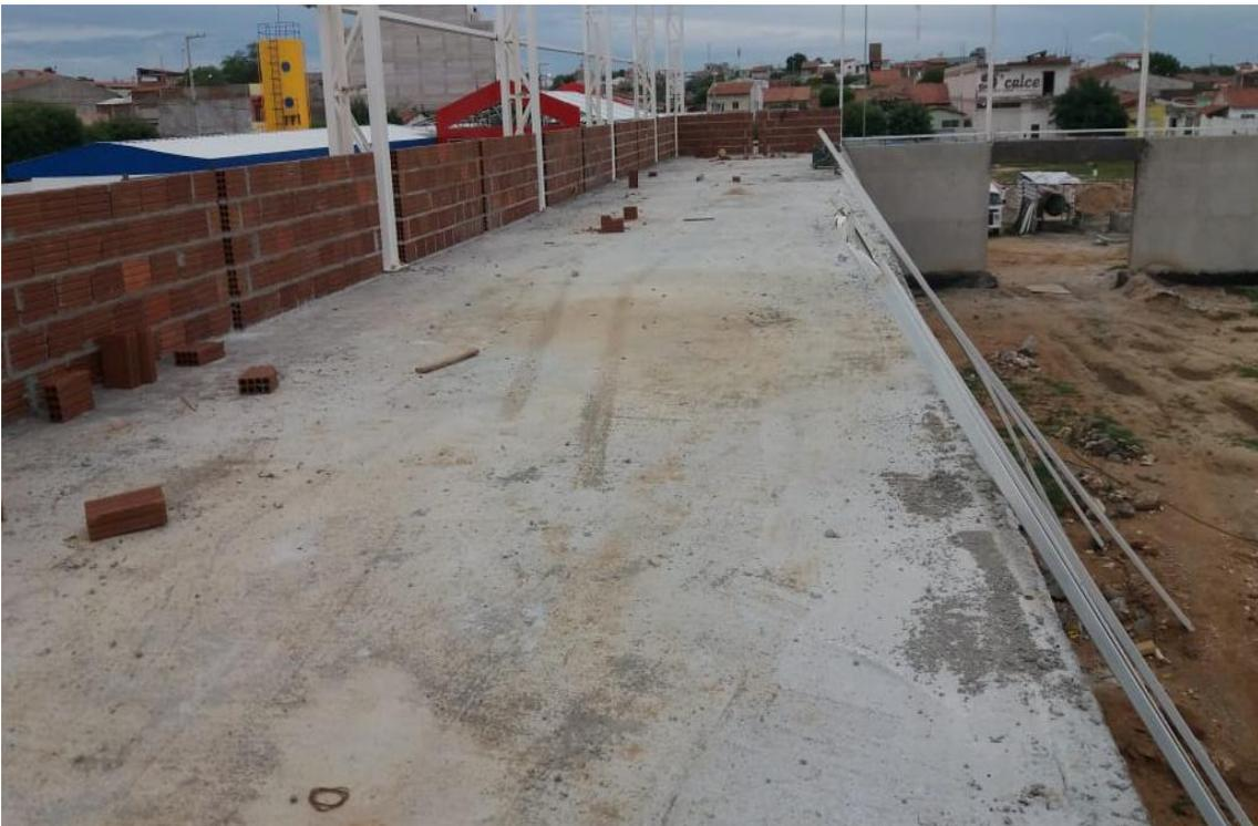
Foto 04 – Superestrutura, fechamento em alvenaria e estrutura metálica.
