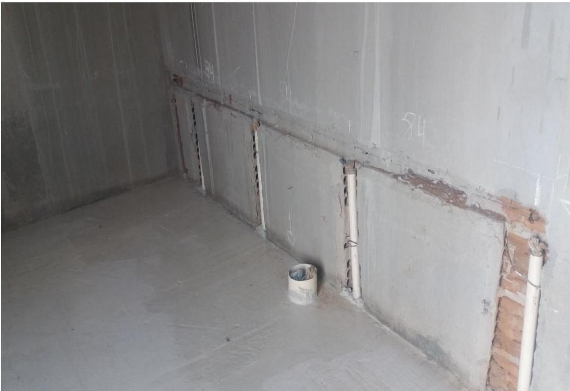
Foto 09 – Chapisco, reboco, parte do hidro-sanitário.
