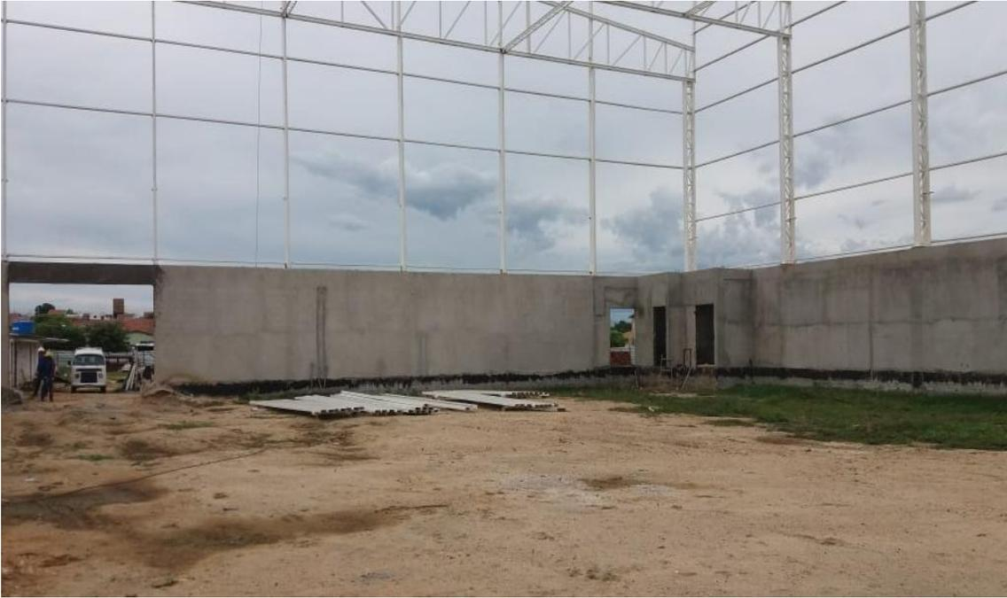
Foto 05 – Superestrutura, fechamento em alvenaria e estrutura metálica
