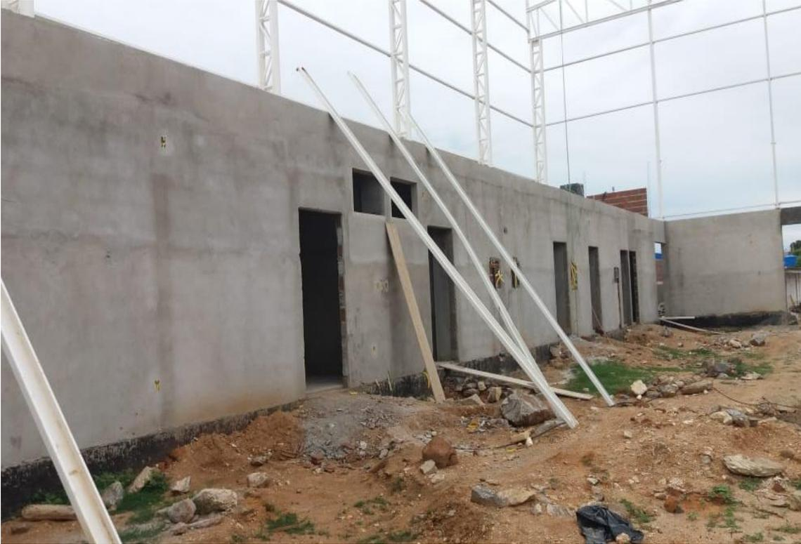
Foto 06 – Superestrutura, fechamento em alvenaria e estrutura metálica
