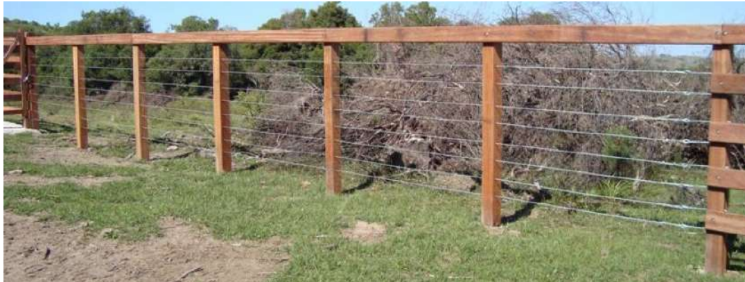
Imagem 3: Fotografia ilustrativa do modelo de cerca com cabos de aço.
