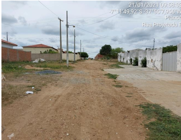
RUA PROJETADA B - BAIRRO OURO BRANCO
