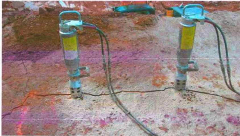
Figura 1 - Rompedor pneumático com cunha hidráulica
